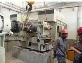
现场指导安装
